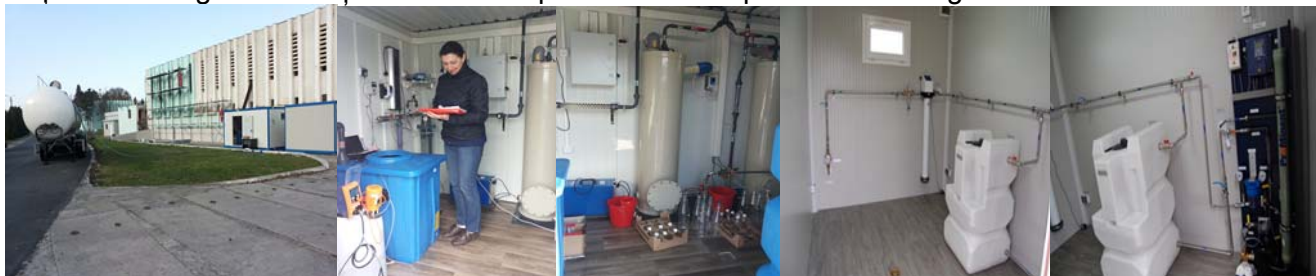
Figura 1. Stația pilot, tratare convențională și tratare avansată (locație SC AQUATIM Timișoara)
